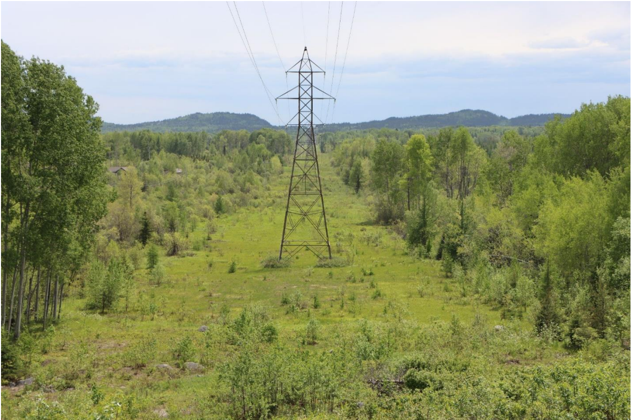
Figure 10. Emprise de lignes de transport d'énergie située près du chemin Jason ayant les caractéristiques de l'habitat de l'espèce : une ouverture, une lisière de forêt et de la végétation peu dense et éparse (CREAT, 2022).
